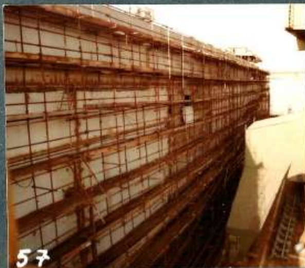
Statek w budowie. Badanie stanu cieplnego burty. 4
