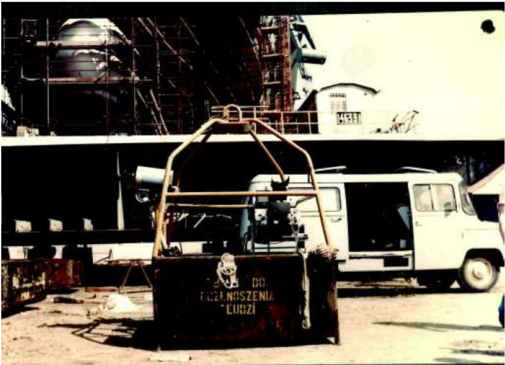
Badanie statku w budowie z kosza „tylko do przenoszenia lu
